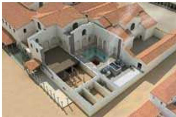
Vue d'une salle de bains chauds des thermes de Cluny et des espaces techniques de chauffage de l'air et de l'eau.
