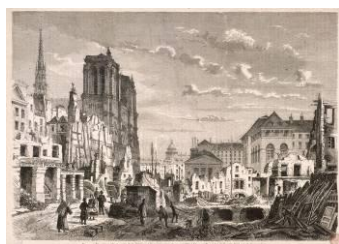
15-Félix Thorigny (1823-1870), Démolition de la Cité pour la construction du nouvel Hôtel-Dieu , Paris, musée Carnavalet © Musée Carnavalet / Roger-Viollet
